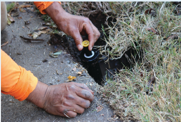
Reparación de un aspersor
